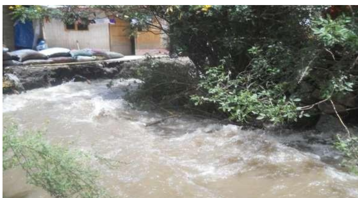
FIGURA N°03: SE OBSERVA EL MATERIAL COLMATADO EN EL CAUDE DEL RIO MANZANO, LA EROSION DEL TALUD DE LA RIBERA EN AMBAS MARGENES.
