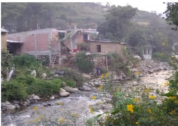
FIGURA N°02: TRAMO CRÍTICO EN EL RIO MANZANO, SE OBSERVA EL MATERIAL COLMATADO.
